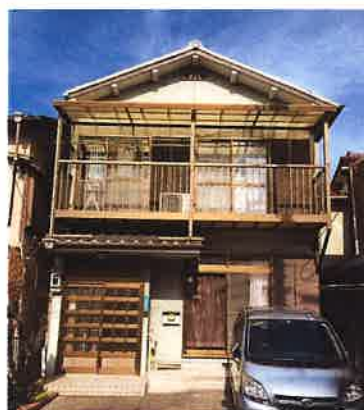
チャレンジホームの建物
